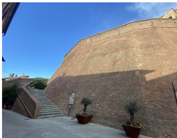
Figura 14 Ingresso con scalinata al Castello dei Vicari
